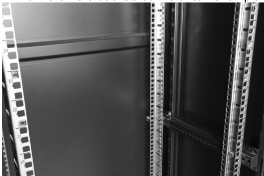
- Setzen Sie die M6 Käfigmuttern ein
