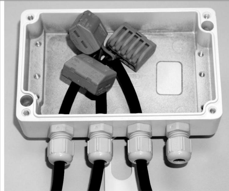
9. (z.B. Einfach) Entfernen Sie die Deckel der Anschlussdose, indem Sie die Schrauben entfernen (4Stk. M4X30).
