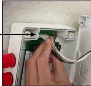
**Um Schäden am Melderkopf zu vermeiden, nicht die Frontabdeckung am Kabel herunterhängen lassen.**
